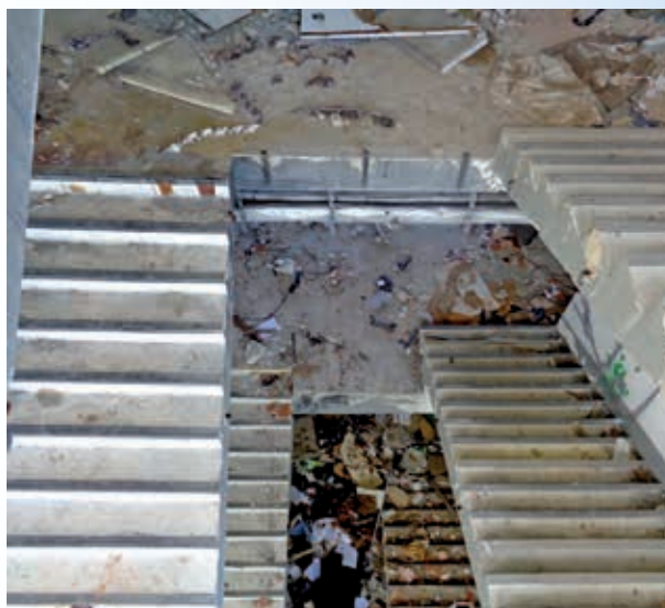
Opustená budova mlynov Košice (Zdroj: Autor)
