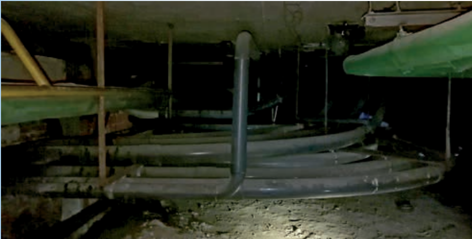
Podzemné priestory UnLP Košice (Zdroj: Autor)
